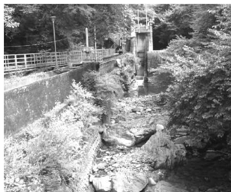
写真-3 坂瀬川承水堰を下流から望む
