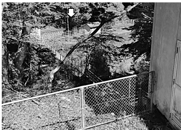
手前の遠隔操作施設から斜め左に承水路橋、対岸に導水路（白矢印）
