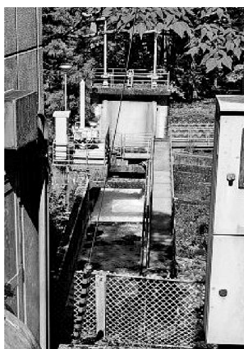
写真-2 河川横断承水路（橋）
