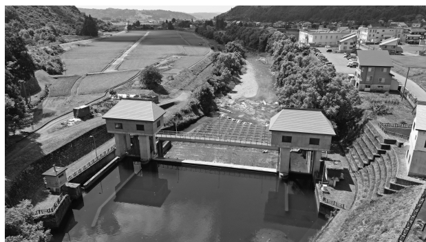
写真-3 小出郷第1号頭首工
