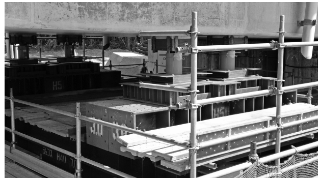
写真-5 島側橋台の仮復旧
