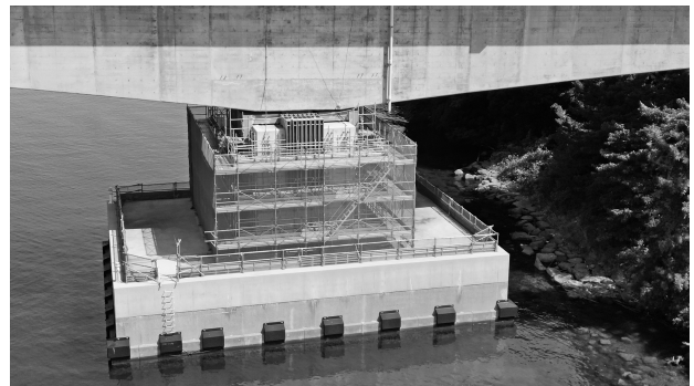
写真-6 島側橋脚の仮復旧
