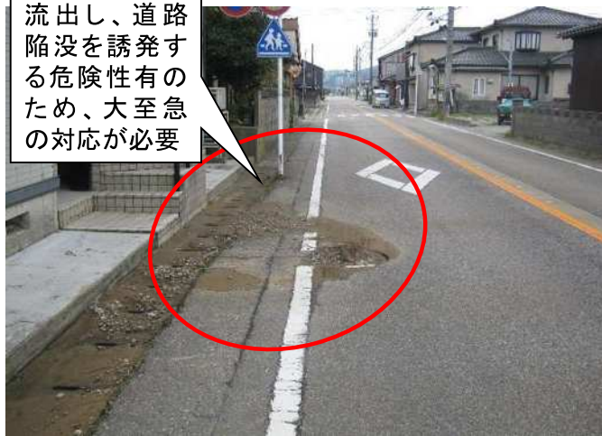
市道試掘調査後、石綿管の破損を確認
