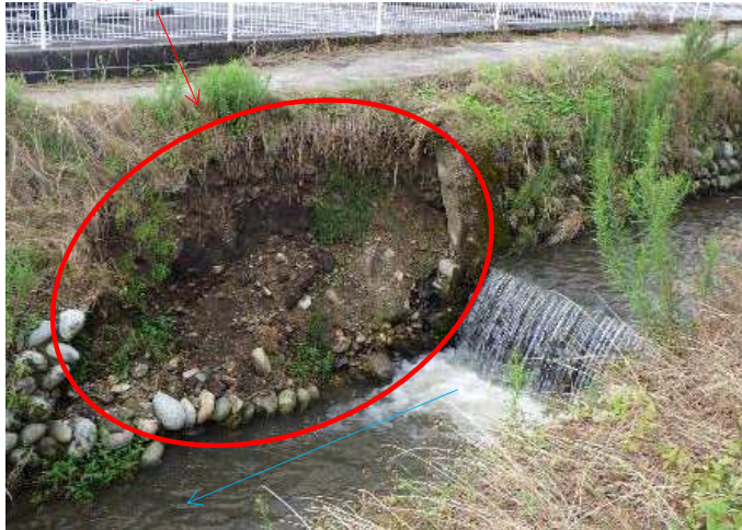
石積護岸の崩壊を補修
