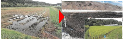
ウ 暗渠排水（事業主体：九戸村、長興寺地区）
