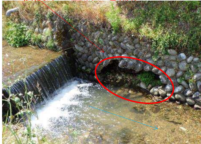
石積護岸の空洞化を補修
