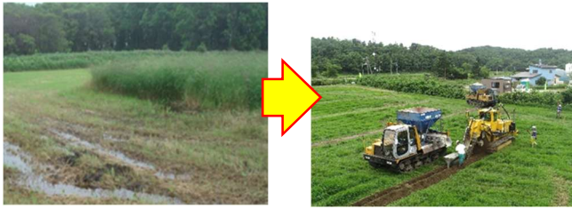
写真-6 暗渠排水を施工し排水不良を解消
