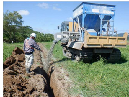
写真-5 暗渠排水の施工状況（幌延地区）
