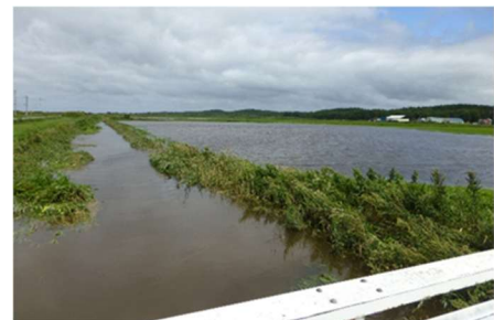
写真-1 排水路の溢水被害
