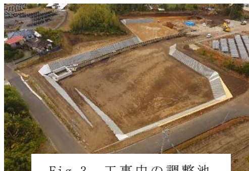
Fig.3 工事中の調整池
