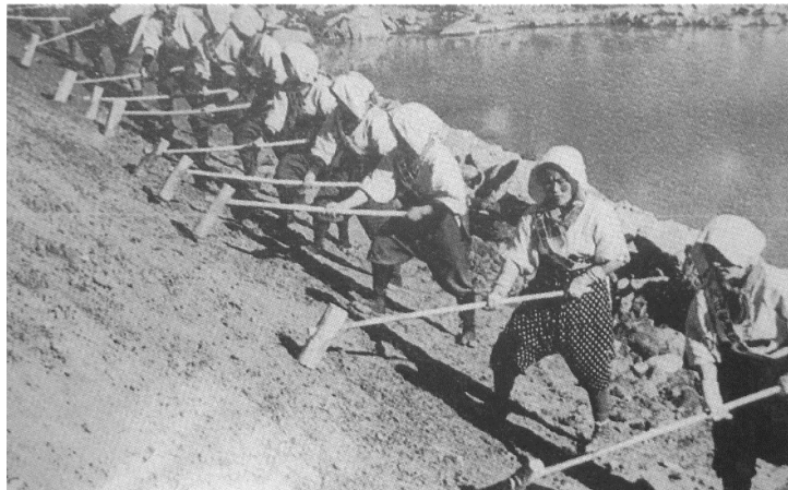
門入池(もんにゅういけ/さぬき市寒川町)の杵搗き作業
