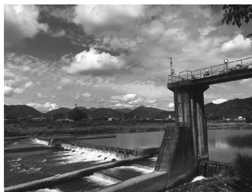
写真-2 戸原頭首工（9月下旬）
