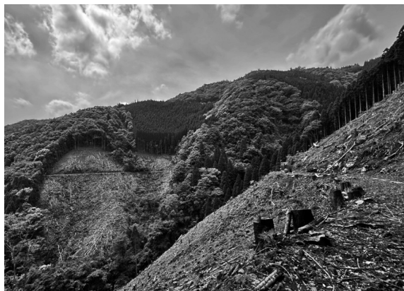
写真-3 蓋暗渠で山腹斜面を横切る大楠用水
