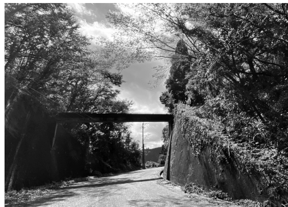
写真-4 集落入口の水路橋（掛樋）
