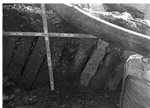
写真-3 河床の集水暗渠
