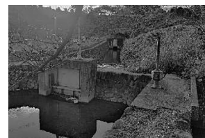
写真-2 下流用水路樋門と余水吐
