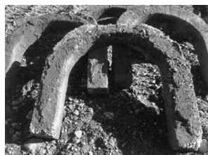
写真-4 集水暗渠の馬蹄形構造
