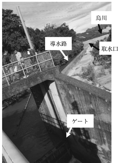
写真-3 烏川からの取水と水位制御用のゲート
