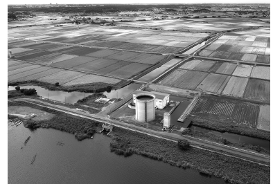
大地を支える吉高機場 (国営印旛沼二期農業水利事業吉高機場) (谷 悠一郎)
