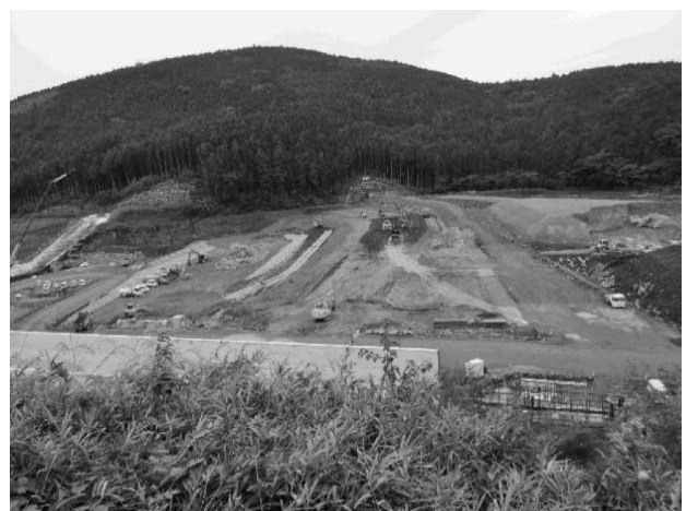
写真-5 堤体盛立工事（令和6（2024）年10月撮影）
