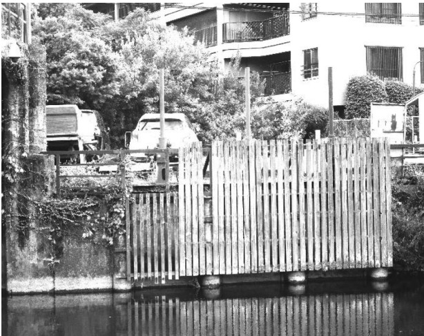
写真-2 右岸幹線水路取水口
