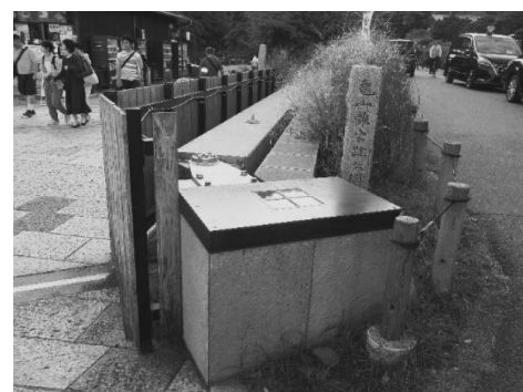
写真-7 格納しているスイングゲート
