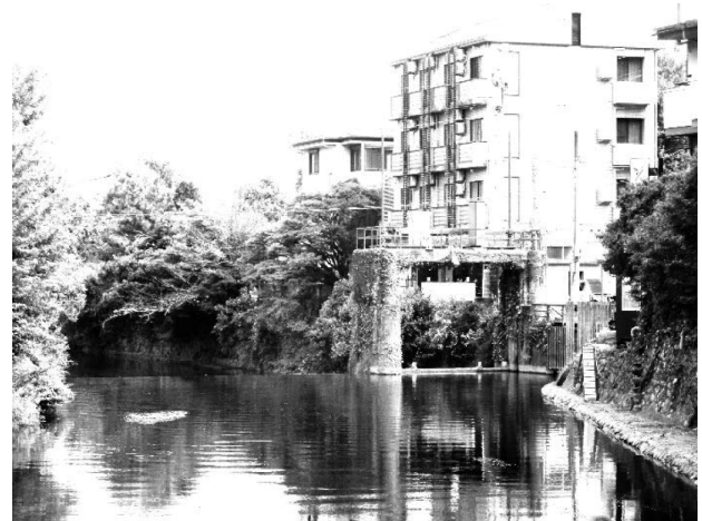
写真-1 右岸導水路（上流から）
