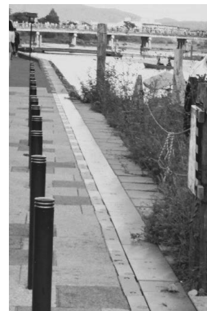
写真-6 格納している可動式止水壁起立部
