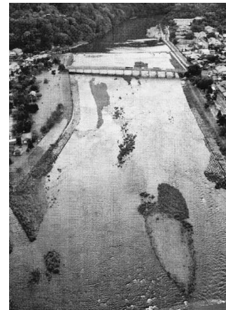
写真-4 整備前の渡月橋上下流を下流側から望む
