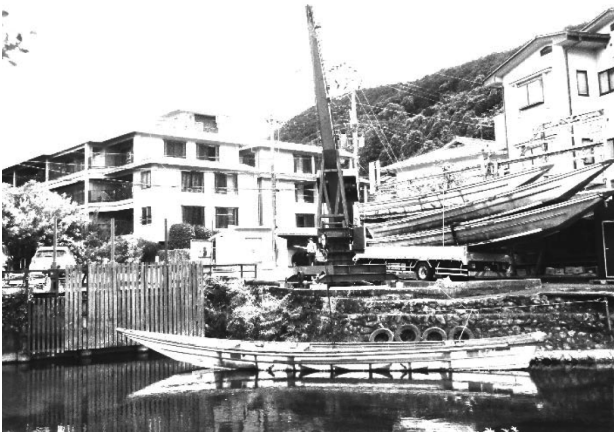
写真-3 右岸取水口設置のクレーン
