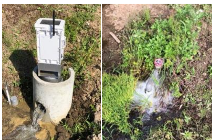
図3 自動給水栓（左節水区）と給水栓（右対照区）
