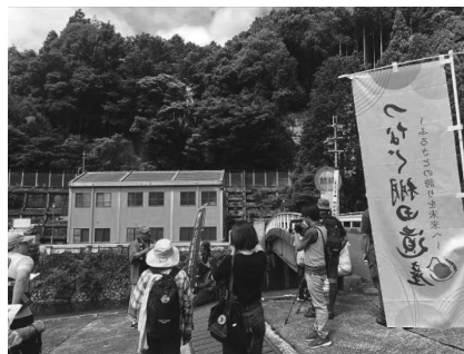
写真-4 関西電力上野発電所
