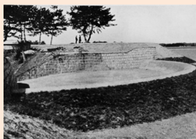
洪水吐（改修後）
