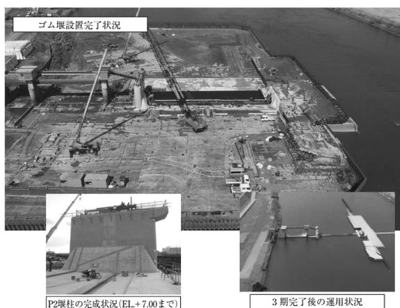
写真-3 ゴム堰の設置完了状況
