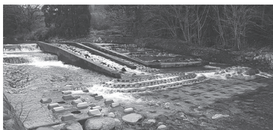
写真-2 タルマル堰堤（改修事業後）
