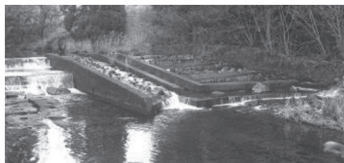
写真-1 タルマル堰堤（改修事業前）
