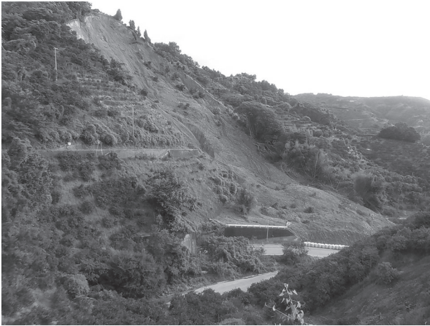
写真-2 白浦工区の被害状況（近景）
