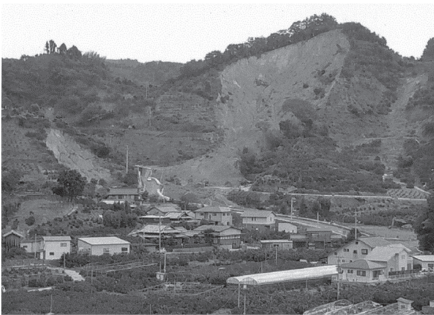
写真-1 白浦工区の被害状況（遠景）
