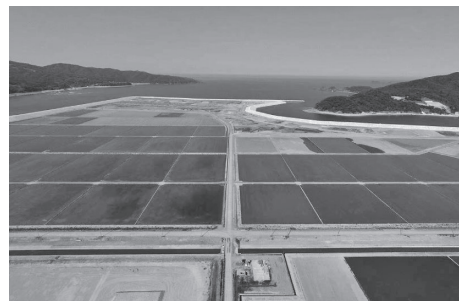
写真-2 干陸後の長面工区（令和2年6月撮影）
