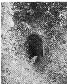
写真-7 西野水道西出口
