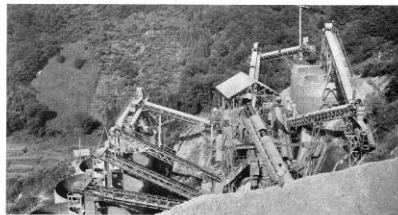
第二次クラッシングプラント全景 索道にて運ばれた骨材は、スクリーン、ブロッカーを通じてきれいな骨材が作られる。(左側コンクリート、大砂利、中砂利、小砂利、砂のストックピジ・右側コンクリート・砂ピジ)
