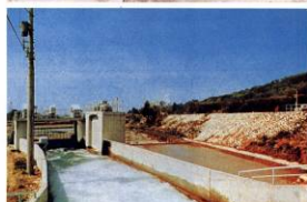
早月川発電所の放水口
