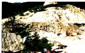
山腹斜面の崩壊（松江町）
