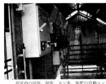
温室内の温度、湿度、カン水、施肥の自動コントロール室内：左側にある大きな数値がカン水、施肥の制御盤 (イタリア農業工学研究所)
