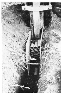
オホーツク沿岸の重粘土地における 土管暗キヨ建設作業状況
