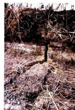
1 堤防の上流法面の崩壊（はらみ出し）
