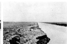
小型ポンプ船で掘削された支線排水路。
