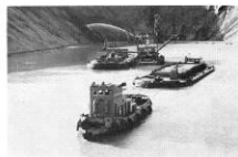
ポンプシヤンプ船と約100mの水土管で接続しているサンドローダー（海陸両用）の作業状況とミキサー（40Tディーゼル250ps）・土運船（200m 3 級）
