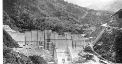
大日川ダム 下流側より見た所である。現在コンクリート打設は、25 万 m 3 に達し完成にあと一歩の時間である。(1966. 9. 1)
