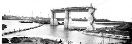
左の図に示した全景。右端は最大径11mのホース（中略）は17m、中央は10m、右30m、21m、左10m、はプレバクト工法による鋼管パイプの鋼管位置。左端下はホースの位置、右端上はパイプの位置。
