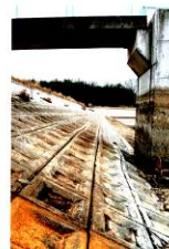
1 堤防の上流法面の崩壊（はらみ出し）
