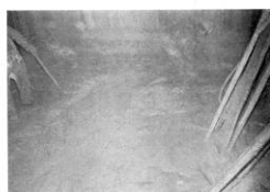
高圧注入前の砂レキ層
