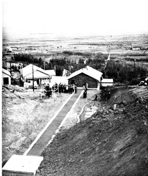
ウブシのポンプ送泥客土全景（本文 pp. 2～14 参照） 周囲に水田に囲われている中央の建物が送泥ポンプ場 手前は土盛り場とウブシポンプ 送泥は客人泊地（送泥パイプが見える）
