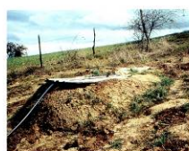
チリ、第 5 州の井戸型貯水機：井戸の中にセニール役を設置して雨期の湧出水を貯留し農業に活用するための装置
