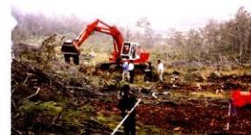
1. 機械力による不耕起造成法（青森県 八甲田山麓）
