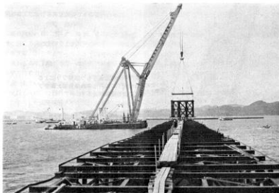
起重機船（250t）で鋼製ワウのすえ付実施中。据付けに当たっては、まず定位位置に位置させて、潜水夫が基礎とのあたり工を調査した
