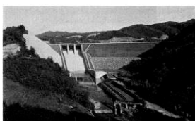
完成の千五沢ダム (堤高 43.08m、未完成にゲートをつけている)
