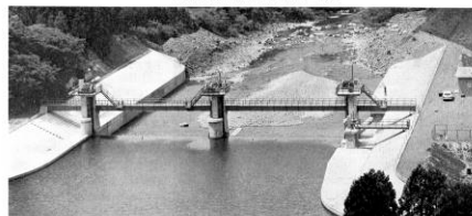
秋田県荒川地区荒川灌漑工
