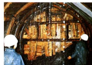
坑口から1140m付近での異常出 水（1000～3000ℓ/min）
