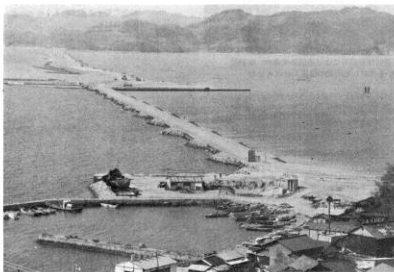
完成工事現場工事完了時の全景（左岸施工地より右岸築島部を望む）。起重量は施工中の車回し力約70t。一ヵ所所施工
