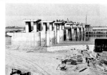
左岸側よりみたセキ柱、右端は取水堰工事
