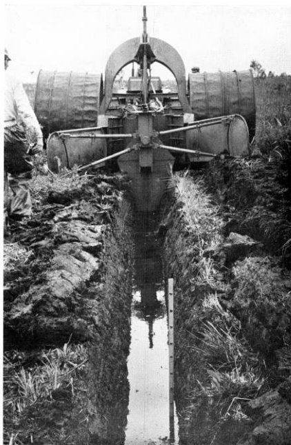
泥炭地における小排水溝の機械掘削試験（本文pp. 52～57参照）
