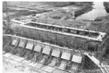
ポンプ本体の建築工事（昭和40年2月）
