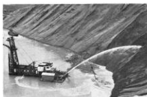
放水路掘削作業中のジェットモーター（最大水平噴射距離25m）とポンプシヤンプ船（土運船）（ディーゼル600ps）
