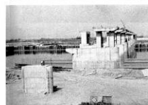
左岸セキ軸よりみた、2期工事のセキ柱、手前は管理橋(幅員30m)のビアー
