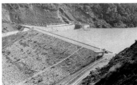
貯水を始めた深山ダム (堤高 75.50m のアスファルト表面シェンロクフィルダム、堤体積 2,000,000m 3 )
