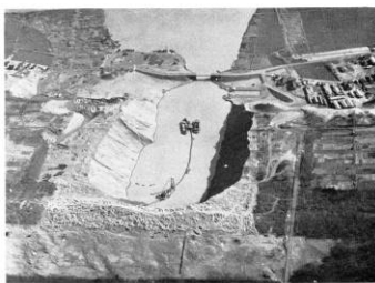
内側砂丘の放水路掘削現場全景。上側は河北潟（S40-12）（朝日新聞社撮影）
