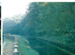
見沼代用水路 ：見沼代用水路の建設は、見沼代用 路の建設を目的として整備し、良好な水辺空 間を形成している。
