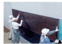
4. 断面補修シート貼付工
