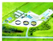
湿式メタン発酵によるバイオガス試験プラント（北海道開発局）
