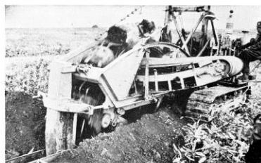
オホーツク沿岸の重粘土地における 土管暗キヨ建設作業状況
