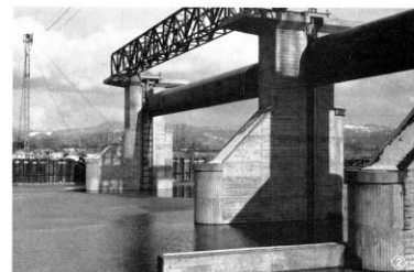
下流側から見た芦野頭首工左岸側
