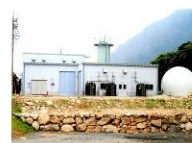
乾式メタン発酵および炭化装置を備えた有機性廃棄物炭化バイオ（ロト）プラント（徳島県開発局）
