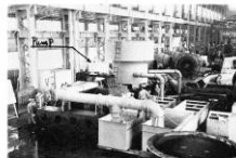
現地に据えつけたポンプをまず工場にて性能テストを行った。口径3,600mmセドルポンプ（昭和39年3月）
