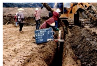
合成樹脂管暗渠とソグ排水材
