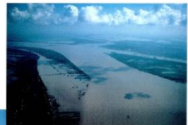
1. 雨季におけるメコン河の氾濫状況(1994年10月撮影) (チャウドムク地点、手前がメコン河、奥がトンレサップ川)、奥左手が(1)サック川)
