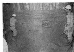
高圧注入により固結した砂レキ層
