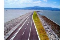
5. 平成17年3月撮影 堤防の潮止め地点の様子
