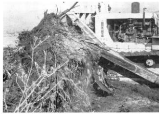
レーキによる抜根 (根株が積載する直前)
