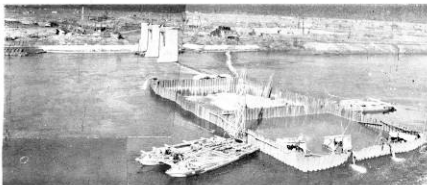
左の図に示した全景。右端は最大径11mのホース（中略）は17m、中央は10m、右30m、21m、左10m、はプレバクト工法による鋼管パイプの鋼管位置。左端下はホースの位置、右端上はパイプの位置。
