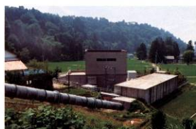
早月川地区（国営早月川農業水利事業）の早月川発電所と調整池
