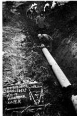
幹線パイプ埋設工事
