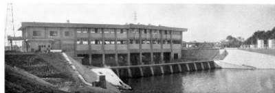
完成した大和田排水機場取水側（昭和38年3月）
