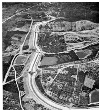
埼玉県荒川水門 埼玉県荒川水門は、荒川から荒川平野 部域までの約112 km であるが、埼玉県水門 は、荒川から17~18 km の地 点にある水門である。通 水量は 200 m 3 /sec. であり、荒川 水門が通行した荒川の水門の典 型の水門であり、付近に は、荒川水門も見られる。
