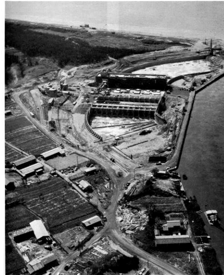
施工中の新川河口排水機場の全景
