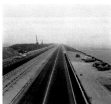
Zuidersee Project の船切り堤防。延長 30km、幅員 100m、堤防の上は自動車道になっている。
