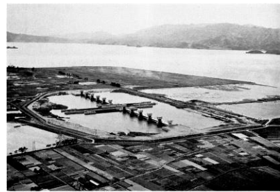
中 國 水 門（49年度完成予定） 水門全長414m（32m×10門、2段式減速型ローゲート）
