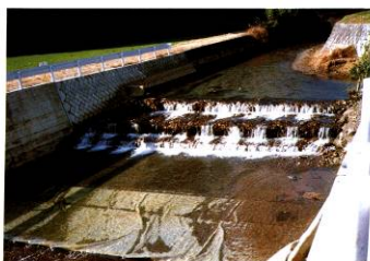
起伏時の状況、上流岸止めはフロン線(一時河床低下防止)
