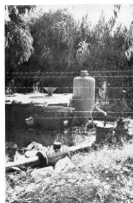
△ 圧力管に空上りを設けて管内の静水圧に照えて いる。左手前は量水器である。
