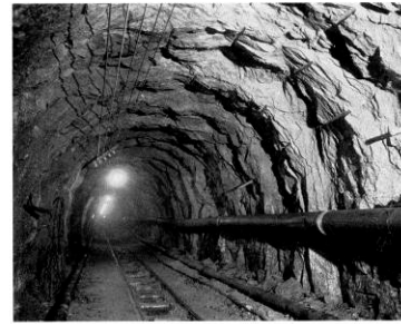
↑ 佐久間導水路における無支柱区間の掘削面（ノミ跡がはっきりわかる）
