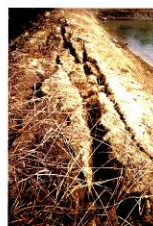
4 口部地の上流法面の堤防クラック
