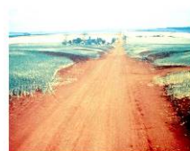
ブラジル、パラナ州の農道の沿線：左右の水路デラスに接続する路面を少し高くした堤防排水の設置
