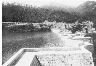
豊稔池多拱式石堰堤
