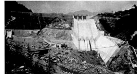
ダム全景、下流より上流を望む
