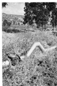
△ 圧力管に空上りを設けて管内の静水圧に照えて いる。左手前は量水器である。
