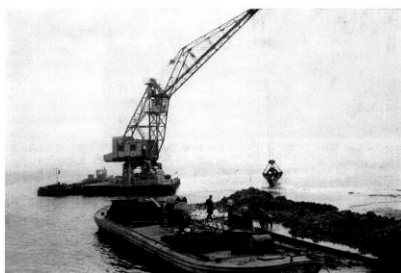
Markerwaard Polder (60,000ha) の基礎工事
