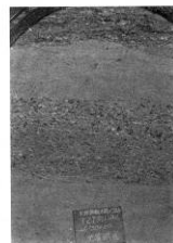
切羽における土層断面の状況
