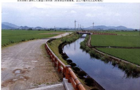
自然景観と調和した農道と排水路（防災保全対策事業、近江八幡市北之庄町地先）
