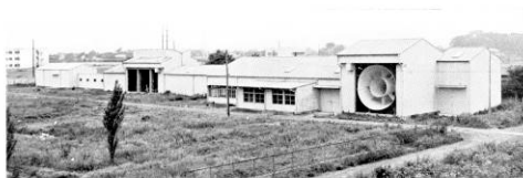
③ 風洞付施設実験室施設全景
