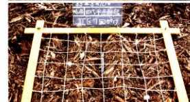
Ⅱ. スタビライズ工法（青森県八甲田山麓地区） 「白く見えるのが石灰岩を砕いた後、この工法は、表土 の有効利用と石灰による土壌酸性中和をねらっている。」
