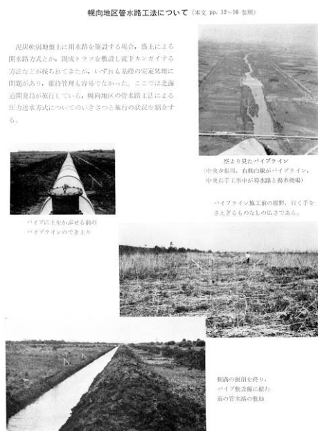
第 33 巻第 12 号 (1966 年) 幌向地区管水路工法 (北海道)
