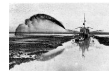
中央干拓地の支線排水路を掘削中の小型ポンプ船 (ディーゼル 140 HP)。排土距離 40 m。
