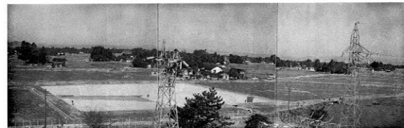
完成全景（左側と下方に流入部があり、右側に出口部がある。このすぐ下に放水口がある）
