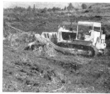
10 ton レーキドーザーによる抜排根作業
