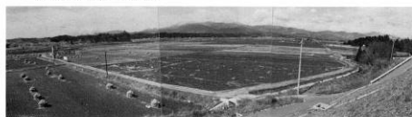
② 水場整備施工後（同上）
