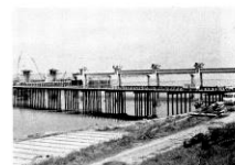
左岸下流よりみた木曾川大ゼキ手前、橋樑は第3期工事用仮設、セキ柱上段に見えるのは、第2期施工のスパン40mの洪水時ゲート
