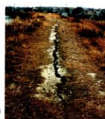
4 口部地の上流法面の堤防クラック
