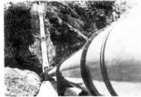
三三川造サイフォン (流量 3.05 m 3 /s、流速 3.50 m/s、管長 330.00 m、落差 300 m)
