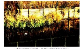
木杭と植生の水質、生物の遷移を可能にする。（静岡県・三島市）
