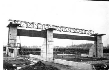
上流側から見た芦野頭首工左岸側
