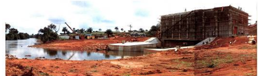
建設中のポンプ場。最大吐出量8.0m 3 /s。1984年7月に完成。現在は稼働している。
