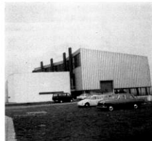
Southern Flevoland Polder (43,000ha) の排水機場 (ポンプ 4 台の排水能力 3,000m 3 /min)
