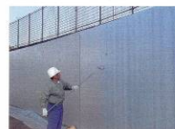
5. 表面仕上げ工
