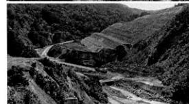
原石山麓地の移転工事
