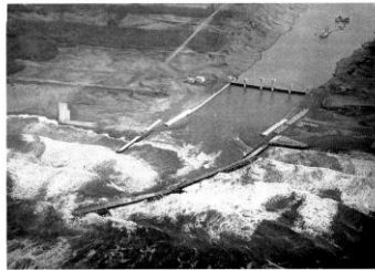
河北潟干拓の排水機場建設。内陸排水を促進する延長1,670m、幅員110mを有する排水路は、河北潟水面積を約1/3に縮小したために増大した洪水量700m 3 /sを日本海へ減下させるために、新設された。その河口部は、日本海特有の冬期低水位による河川閉鎖の防止対策の必要であり、電機は14年、冬期閉鎖による河川閉鎖を計った。左岸堤防延長約250mをW60°～75°N～方時分、右岸堤防延長約90m（計道延長180m）も設け入居可能。防砂防止および結成効果の面からW55°N方向に設けられた。河北潟干拓事業も本年では、干拓堤防を含むこれら関係工事の完成とあいまって、いよいよ約1,420haの干拓を開始する。
