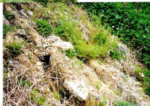
農地斜面の土壌の浸食状況 (シロゾメックスや雑草が発生していない部位では浸食が著しい)
