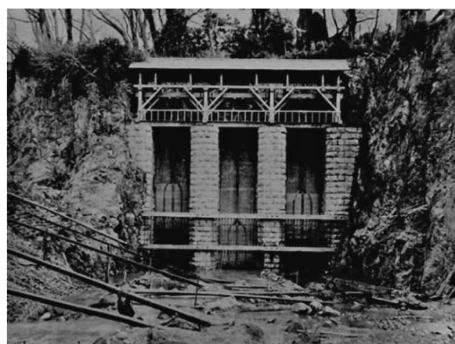
写真-1 竣工間際の大水門（明治34（1901）年5月）
