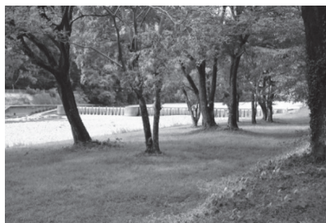
写真-2 移植保全された榎林「いかざきの杜」から見た龍宮堰
