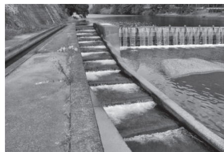
写真-3 龍宮堰の魚道
