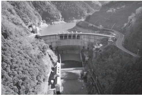
写真-4 改修後の減勢状況
