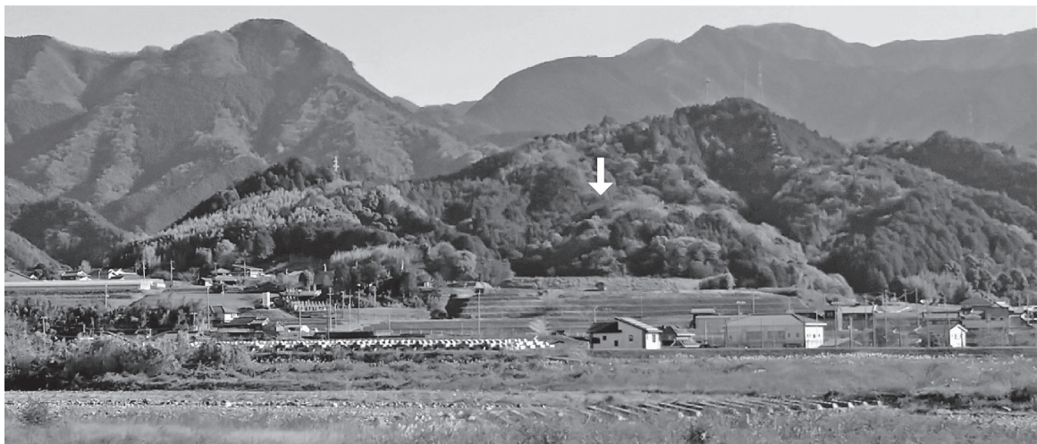
写真-1 重信川右岸から見た下林岡池（中央部の家の上部に図示した矢印位置）
