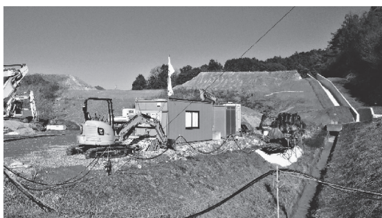
写真-4 施工中の洪水吐（写真右側の水路）と斜樋底樋（左凹部）
