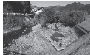
写真-2 拝志川の取水堰
