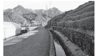
写真-3 市道に沿う導水路
