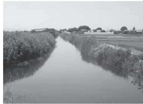
写真-1 備前渠用水路(熊谷市)
