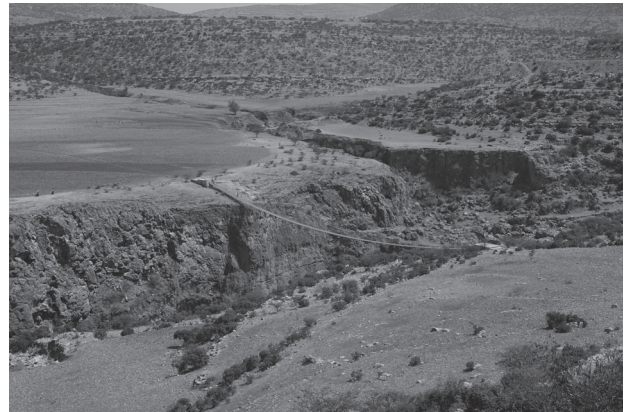
写真-1 カワトレイル橋
