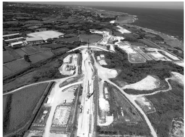
写真-1 沖永良部島の農地と地下ダム建設地
