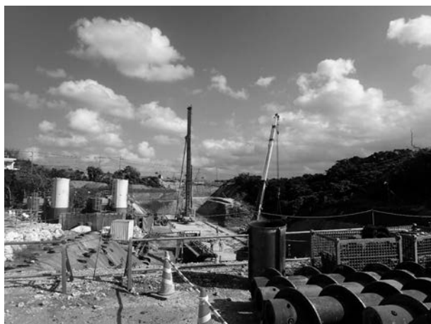
写真-2 地下ダム（止水壁）建設現場
