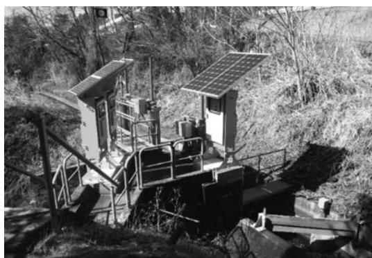
写真-2 遠方制御が可能となった排水ゲート
