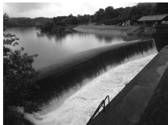
写真-2 満濃池余水吐の洪水時流況
