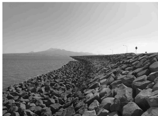
全長約 7 km の潮受け堤防は伊勢湾台風級の台風を想定し天端高が決定されている。
