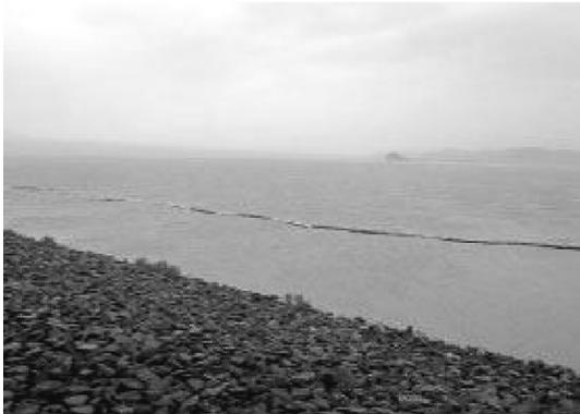
写真-3 と同時刻。潮受け堤防背面の調整池は高潮の影響が遮断されている。
