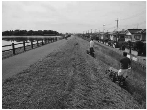
写真-4 長大堤体法面を乗用草刈機で
