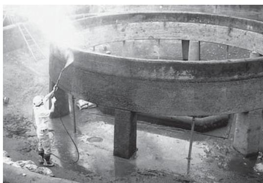
写真-2 補修時の円筒分水（高津区ふるさとアーカイブ提供）
