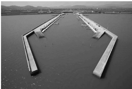
写真-1 白石排水樋門の全景
