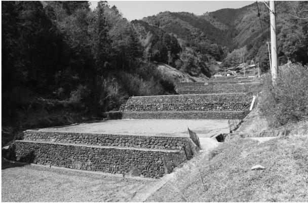
写真-5 段抜き（石積みが2段積みと高くなった，榎谷）
