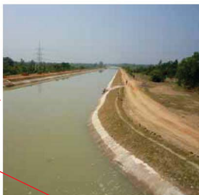
幹線水路の通水
