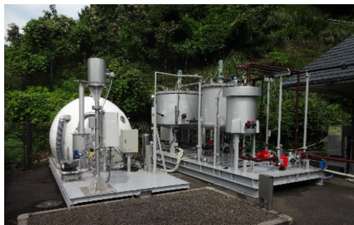
写真2 是川氏をご講演で紹介された、小規模メタン発酵システムの実証試験装置
