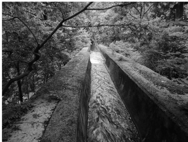
写真-1 水路閣の上部
