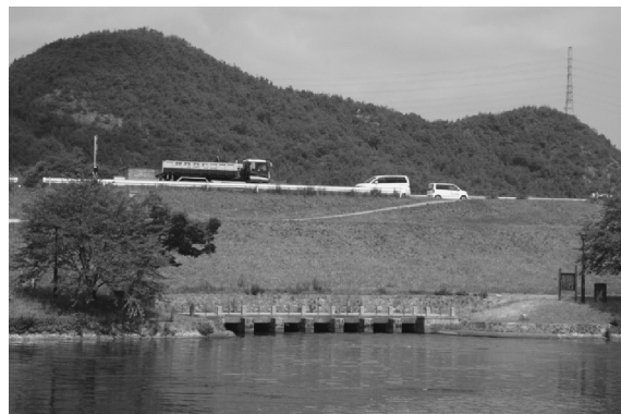
写真-3 取水樋門と酒津配水池
