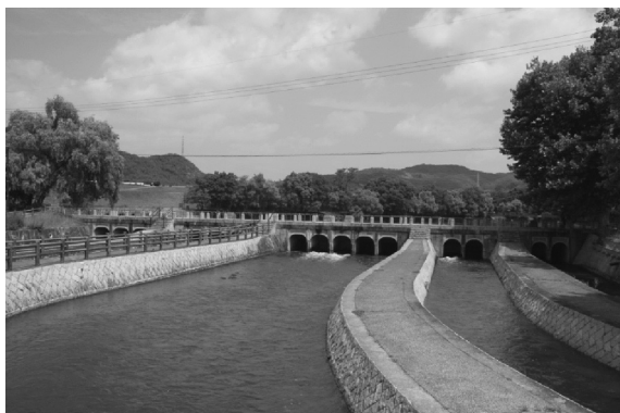
写真-2 酒津樋門の南樋門
