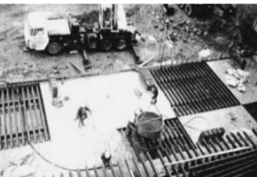
写真-2 耐摩耗レールの設置（左）と洪水吐の落石緩衝スクリーン（右）
