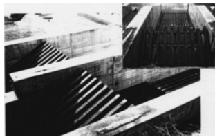
写真-2 耐摩耗レールの設置（左）と洪水吐の落石緩衝スクリーン（右）
