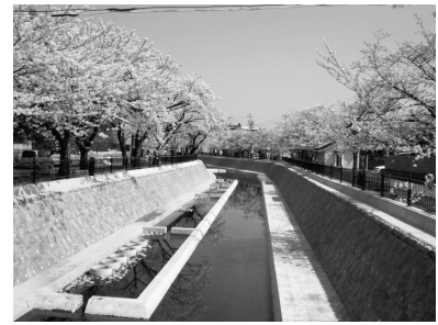
写真-5 整備された大江排水路の緑道区間
