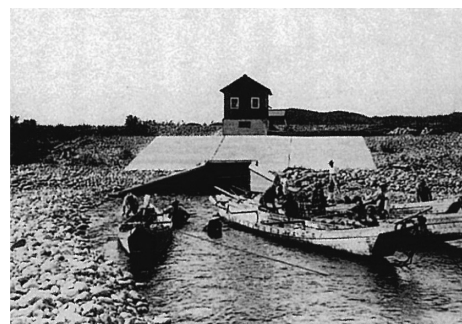
写真-1 羽島用水頭首工（昭和41年撤去）
