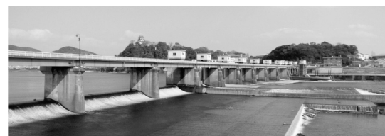
写真-2 犬山頭首工（右岸下流より）
