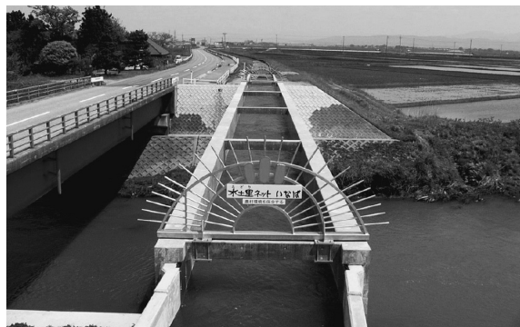
写真-2 古郡藤島川水路橋 (旧名称：古郡大樋)
