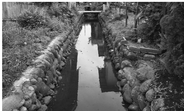
写真-4 開墾当時の石積み水路
