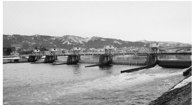
写真-1 赤川（合口）頭首工
