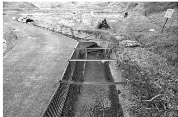
写真-4 排水路に設けられた小型階段式魚道
