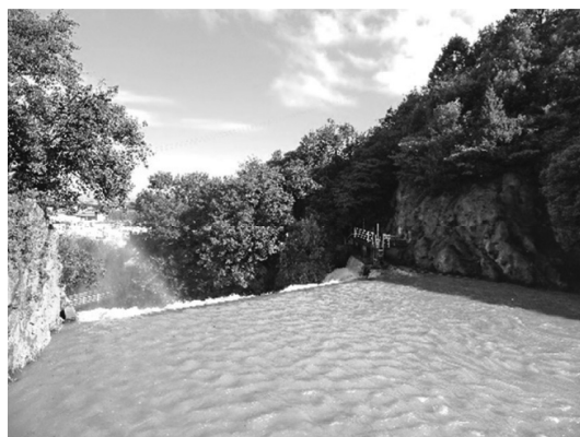
写真-2 両側壁が岩肌のままの東余水吐 (和泉層群砂岩泥岩互層)
