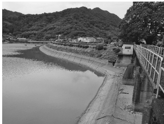
写真-1 東余水吐とアーチ型堤体
