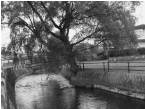
写真 3 古木を活かして改修した内川
