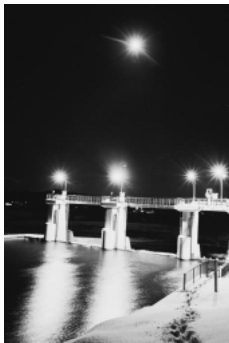
写真 4 ライトアップされた洪水吐土砂吐
