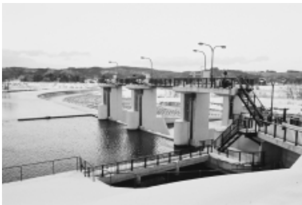
写真1 大堰頭首工全景
