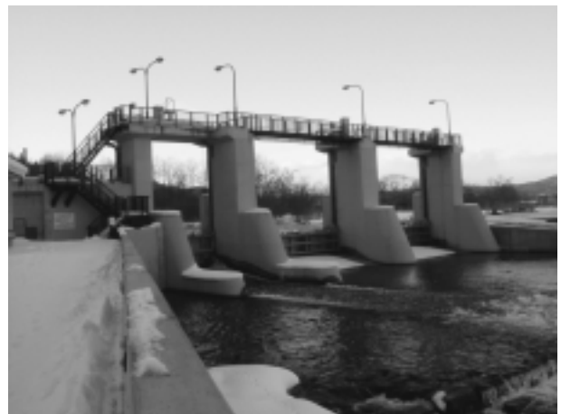
写真2 リニューアルされた土砂吐と洪水吐
