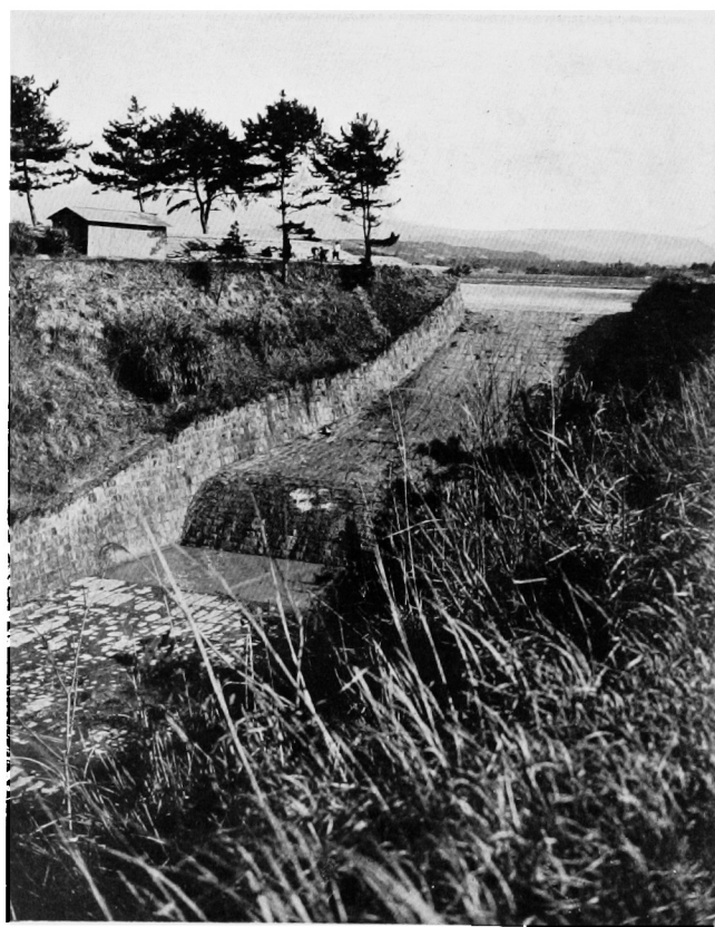
上圖 改造後の狭山池西餘水吐溢流部 下圖 同上的下流部（餘水落下部）
