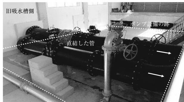
写真-1 幹線水路のパイプライン化後の旧加圧機場の場内
