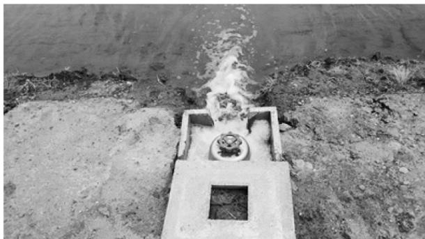
写真-2 末端圃場で整備されたパイプライン給水栓
