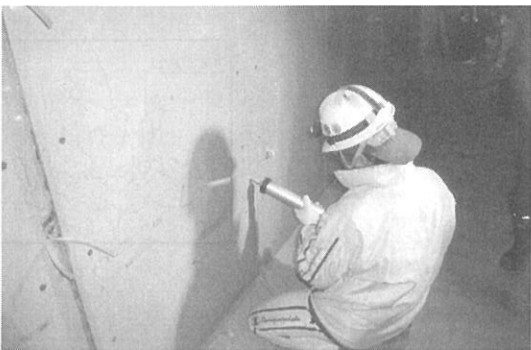
図-5 施工写真-FRPM板ライニング工 (国道サイホン) 目地工
