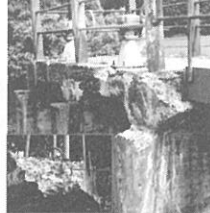
堰躯体の部分剥落（五戸町）
