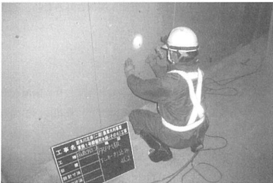
図-4 施工写真-FRPM板ライニング工 (国道サイホン) FRPM板ライニング、アンカーボルト取付
