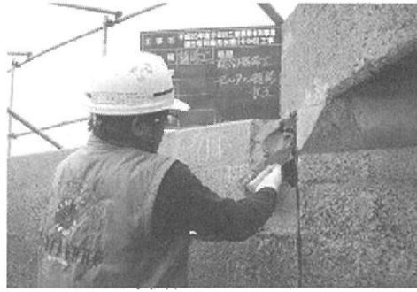
図-20 表面被覆工-第5号幹線用水路断面補修(モルタル)
