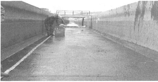
図-16 表面被覆工-第5号幹線用水路全景(着手前)
