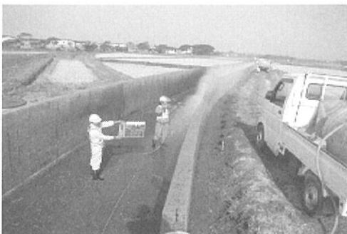
図-19 表面被覆工-第5号幹線用水路高压洗浄
