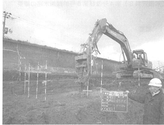
図-12 地盤改良工-パワーブレンダー工法、攪拌混合状況①
