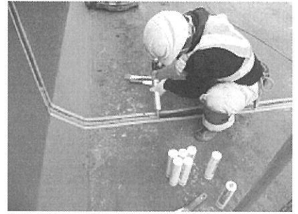
図-26 表面被覆工(エコガード工法)-第5号幹線用水路 継目補修(シーリング)、シリコーン系シーリング材
