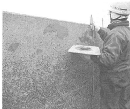
図-21 表面被覆工-第5号幹線用水路下地穴埋め
