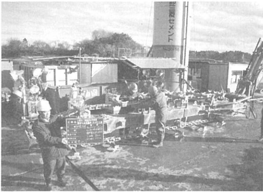
図-9 地盤改良工-仮設備 (全景)、トレンチャー (全景)
