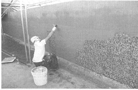
図-23 表面被覆工-第5号幹線用水路地下処理(全面)
