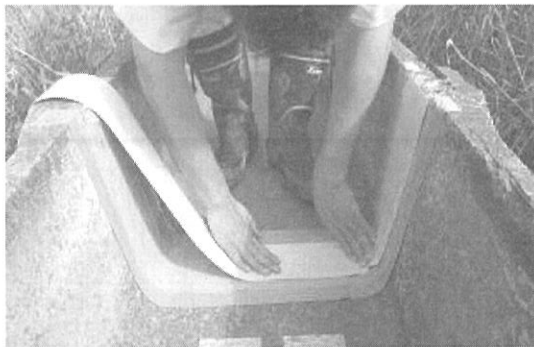
図-13 シートの貼り付け状況
