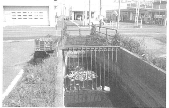
図-2 施工写真-FRPM板ライニング工 (国道サイホン) 全景 (着手前)
