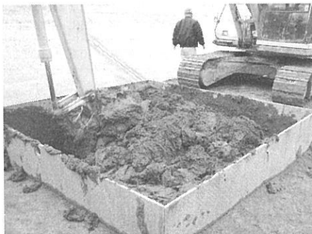
写真-2 攪拌槽での底泥の攪拌混合
