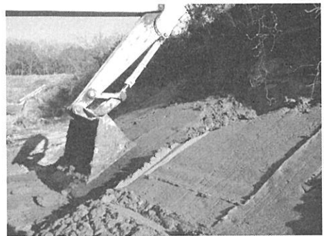
写真-3 貼り付け作業
