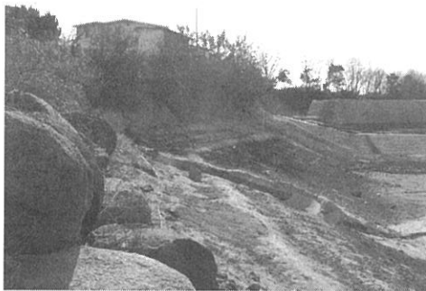
写真-1 護岸貼り付け箇所
