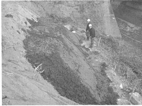
写真-5 貼り付け作業
