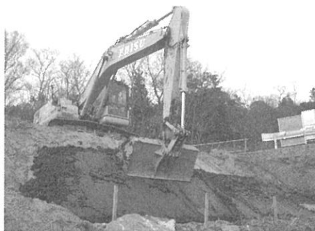
写真-4 貼り付け作業状況
